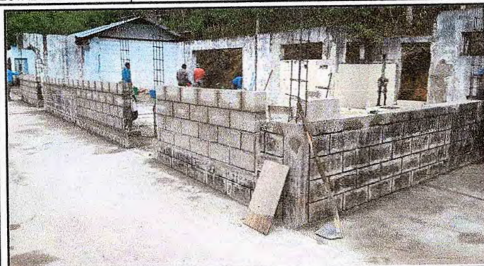
Foto 1: La vista de los dos módulos en avance de la mitad de las paredes.
